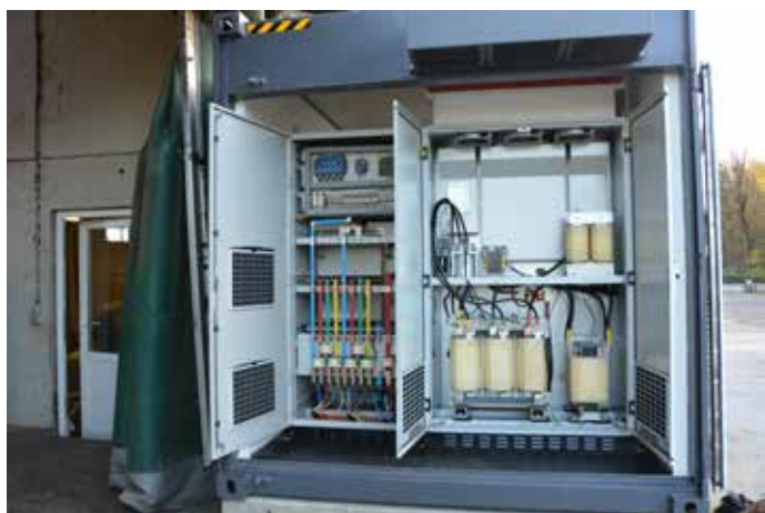
Aan de linkerzijde van de container staan de transformatoren opgesteld. Links (ter hoogte van het groene gordijn) is er een aansluiting voor het noodstroomaggregaat voorzien. Binnen in het gebouw staat het ontkoppelp bord met noodschakelaar.
