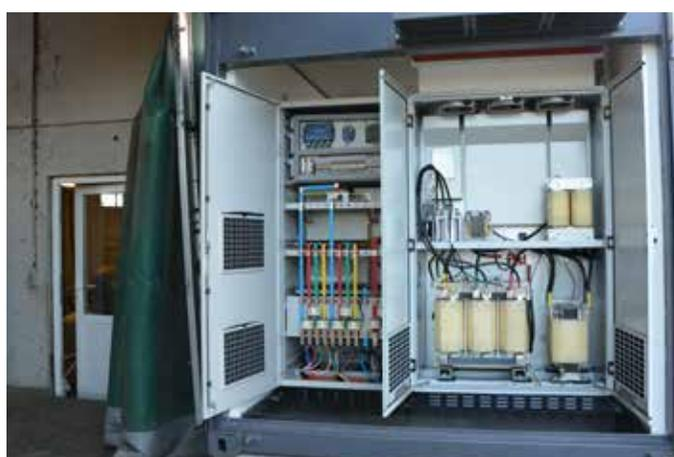
Les transformateurs se trouvent sur le côté gauche du conteneur. A gauche (à hauteur du rideau vert), on voit le raccordement pour l'approvisionnement électrique de secours.
