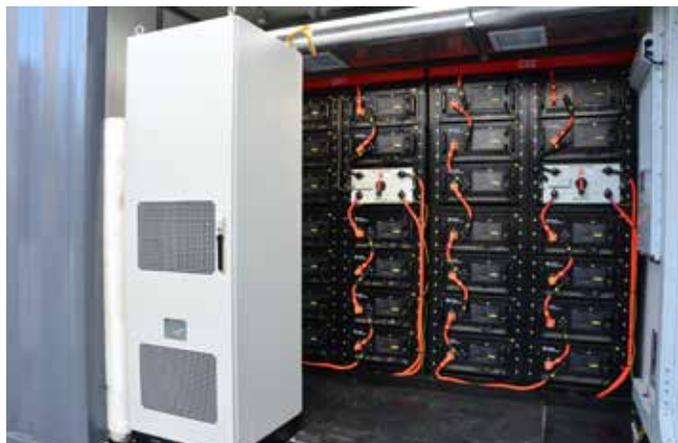
Le conteneur est subdivisé en plusieurs parties. La partie droite est occupée par les batteries. Cette zone est entièrement climatisée et munie d'une installation d'extinction automatique. Contrairement aux batteries lithium-ion qu'on trouve dans les voitures électriques, les batteries lithium-fer-phosphate peuvent être arrosées et éteintes.
