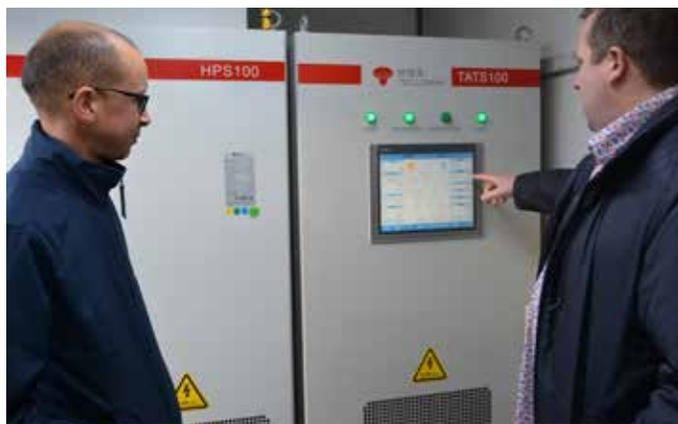
Bert peut suivre l'état de l'installation sur l'écran de l'armoire de commande. Il peut choisir de d'abord charger les batteries, une option intéressante en cas de tempête imminente ou lorsqu'une interruption de courant est annoncée.
